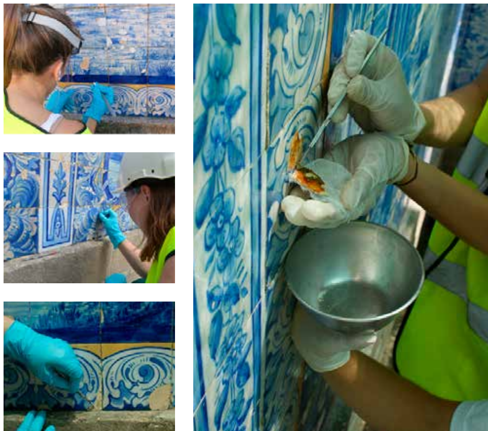
Figura 9 · Limpezas mecânicas, fixação de vidrados e consolidações.
