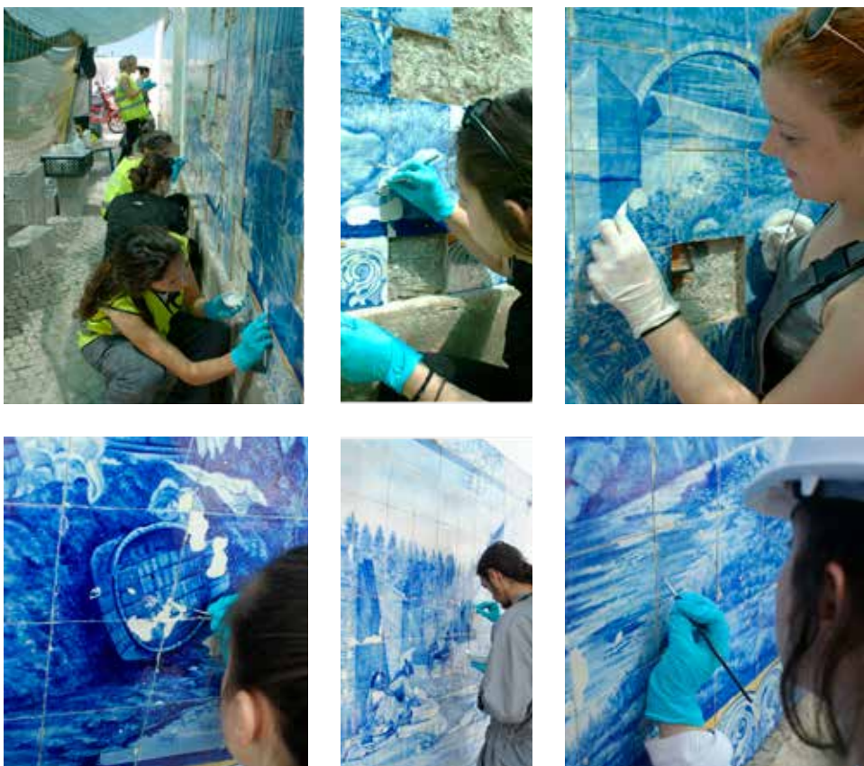
Figura 12 - Preenchimento volumétrico das lacunas, nivelamento e reintegrações cromáticas.
