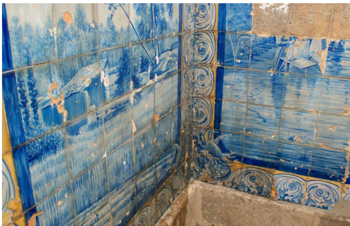
Figura 17 · Concentração de depósitos de poluentes atmosféricos, e de natureza calcária, nas faces vítreas, chacotas e juntas. Painéis 10 e 11 da fachada poente, antes da intervenção.
