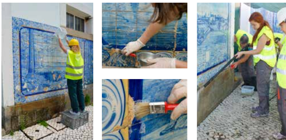
Figura 8 · Limpezas aquosas e aplicação de biocida nos azulejos, e na cantaria.
