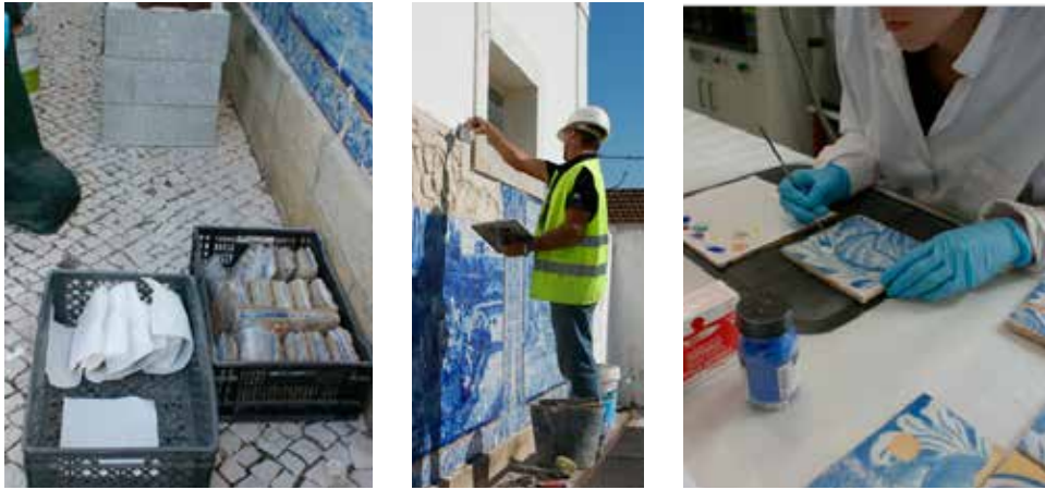
Figura 11 - Preenchimento da área de remoção dos azulejos, e restauro dos azulejos nas oficinas do ACRA.
