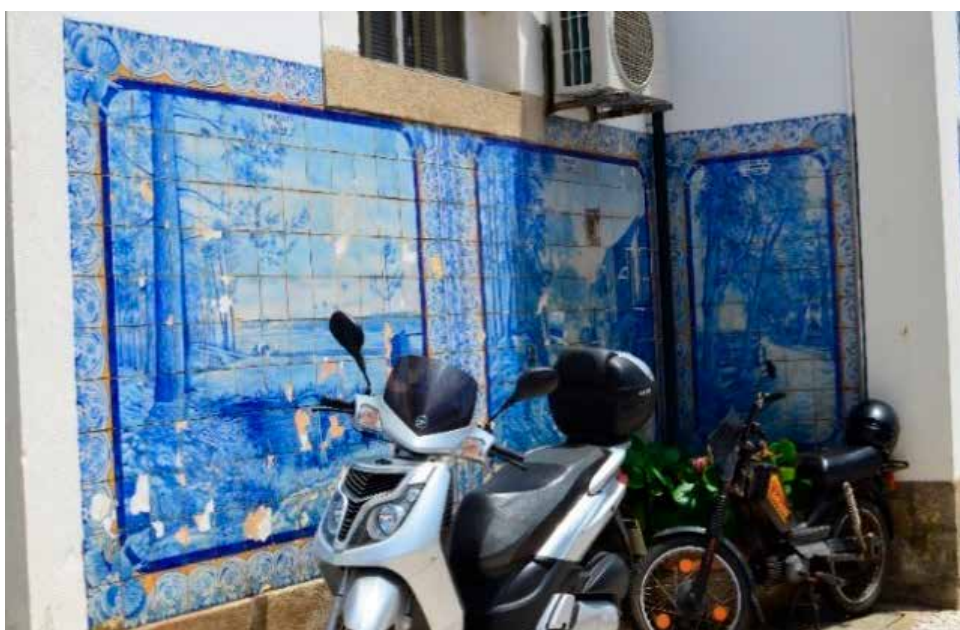
Figuras 20 e 21 - Colocação de motos junto aos painéis da fachada Poente. Fotografia efetuada antes da intervenção.
