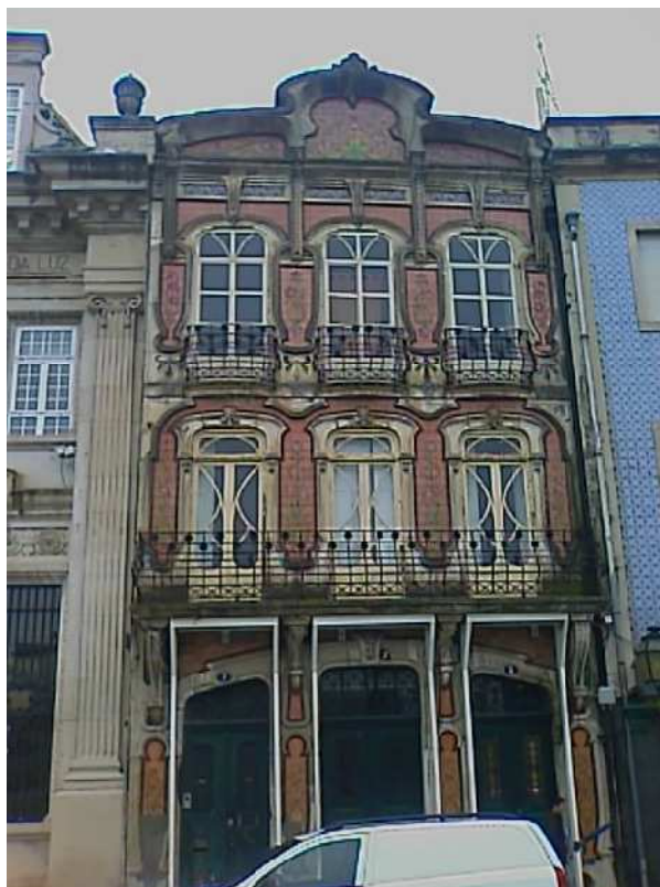
Figura 9 – Prédio da Rua João Mendonça em Aveiro
