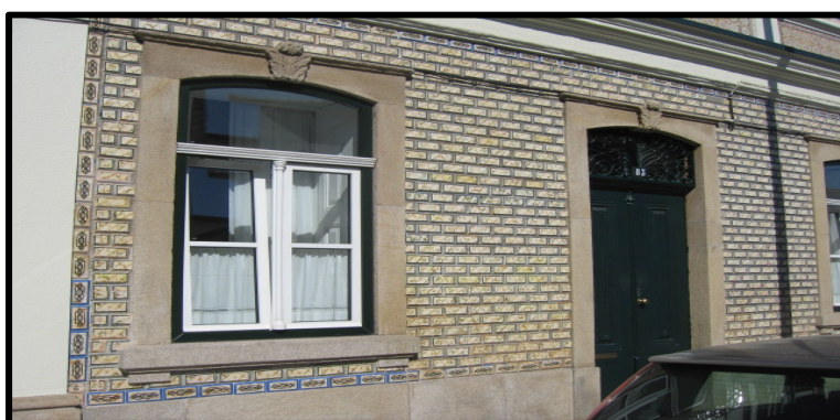
Figura 49: Fachada da casa (RPF)
