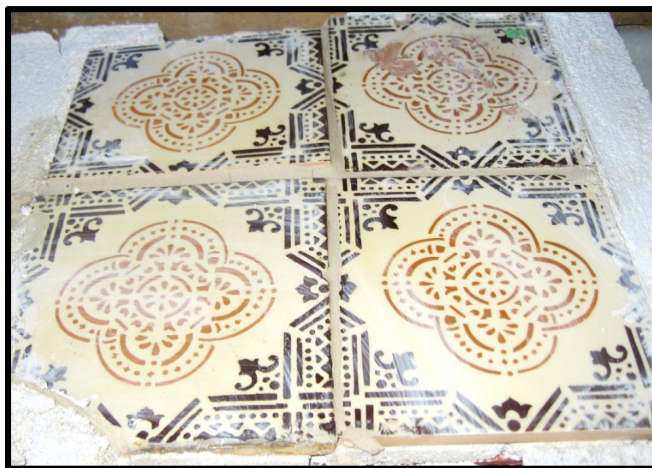
Figura 80: Aspecto final de azulejos com espaçamento de junta 5 mm
