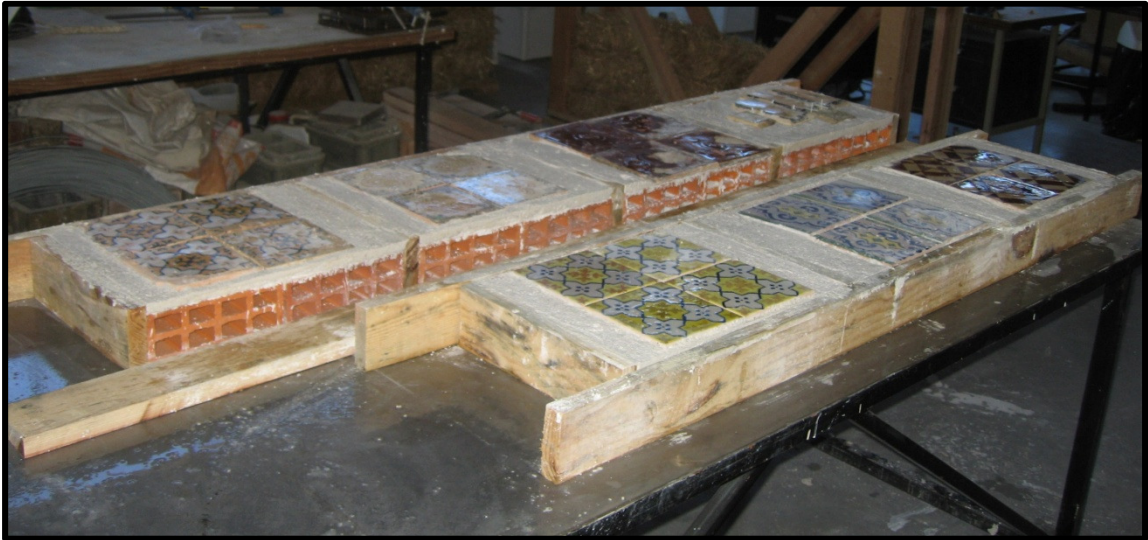
Figura 75: Aspecto final dos azulejos, antes da colocação da argamassa de junta
