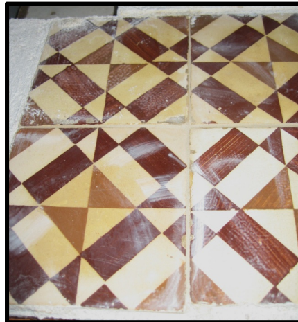
Figura 76: Aspecto final de azulejos com espaçamento de junta 1 mm
