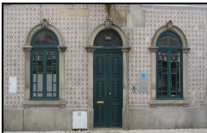
Figura 52: Fachada da casa (REG)
