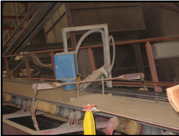
Figura 22: Colocação do pó nas mangas
