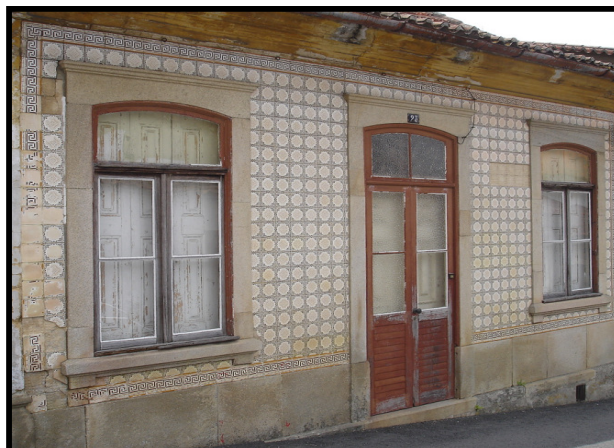
Figura 53: Fachada da casa (RAS)
