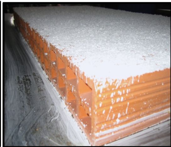
Figura 73: Colocação do chapisco
