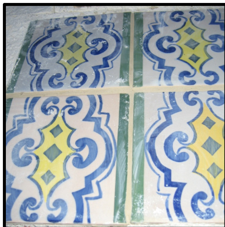
Figura 77: Aspecto final de azulejos com espaçamento de junta 2 mm
