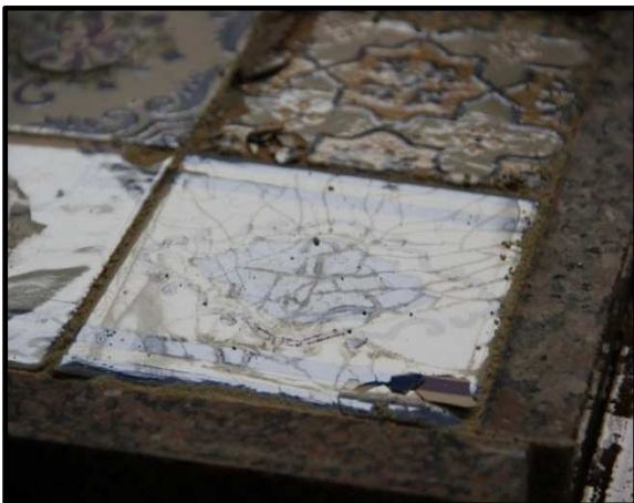
Figura 81. Pormenor de craquelé no sistema horizontal dois
