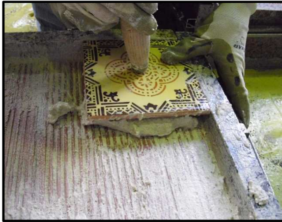
Figura 42. Assentamento de um azulejo – réplica
