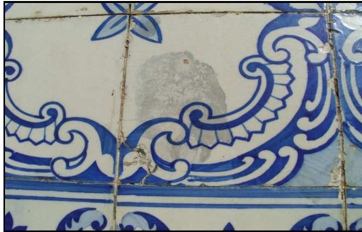
Figura 29. Enodoamento irreversível
