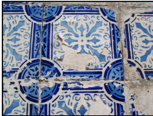
Figura 16. Laminação do vidrado
