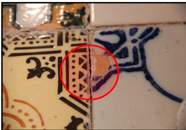
Figura 69. Exemplo de junta de zona Z2 onde foi efetuado o ensaio de absorção de água sob baixa pressão, sistema três
