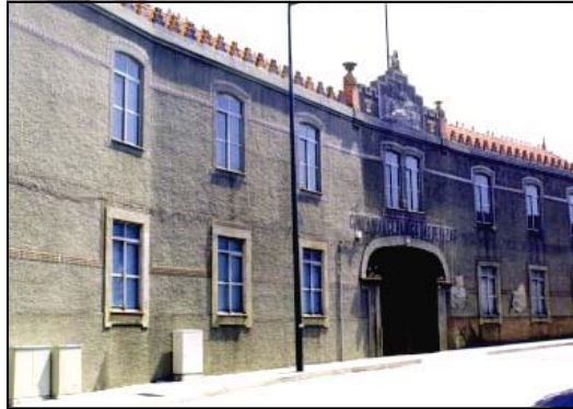
Fig. 15 - Fábrica das Devesas [11]
