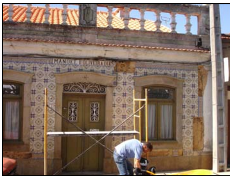
Fig. 40 - Casa alvo de intervenção, Rua Camilo Castelo Branco, Ovar
