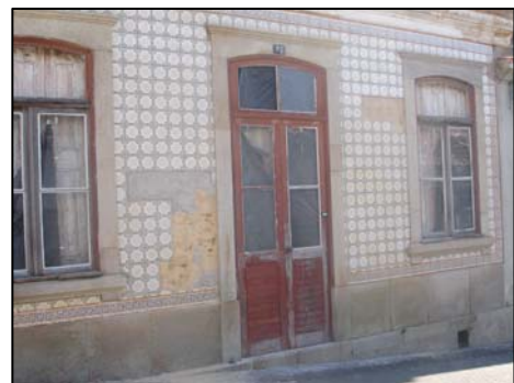
Fig. 41 - Casa alvo de intervenção, Rua Dr. António Sobreira, Ovar
