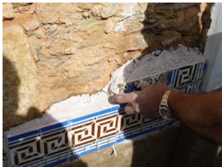
Fig. 67 - Execução de um painel
