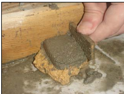
Fig. 27 - Colocação da argamassa de confinamento
