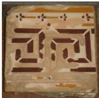
**Figura 45** – Degradação do vidrado da amostra DAS\_Z2\_A4
