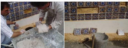
Fig. 1 - Workshop desenvolvido, em 2005, em colaboração com o LNEC, em técnicas de aplicação de azulejos com argamassas tradicionais.
