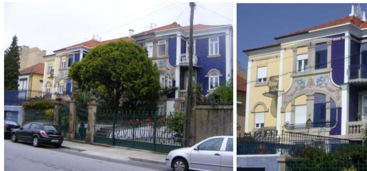
Figs. 6 e 7 - Alteração de um edifício na Rua do Amial, Porto, vista geral e pormenor – mudança do revestimento azulejar original no edifício da esquerda por sistema com isolamento térmico pelo exterior (ETICS).
