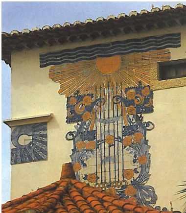
Fig 13 Painel exterior da Casa Montsalvat, Estoril (1901) – Raul Lino
