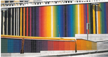
Fig 29 Painel do túnel da Avenida Infante Santo, Lisboa – autoria de Eduardo Nery
