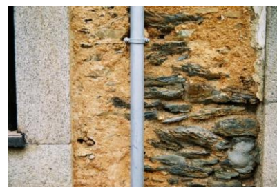
Fig. 16 – Alvenaria de xisto e argamassa
