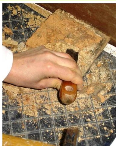
Fig. 20 – Remoção de argamassas do tardo com espátula. (Fonte: ACRA)
