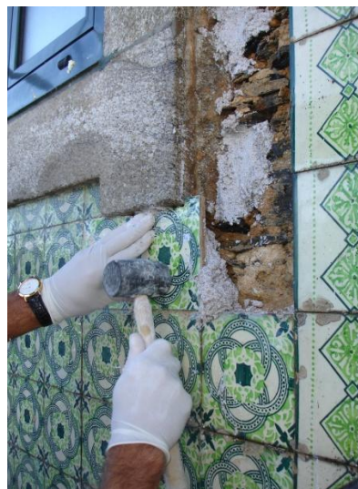
Fig. 22 – Recolocação de azulejos na fachada. (Fonte: ACRA)
