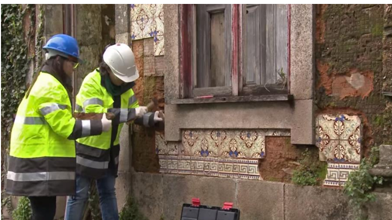
Fig. 23 – Reabilitação de fachada azulejar
