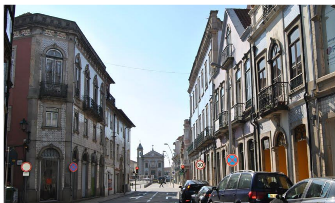
Fig. 18 – Rua Cândido dos Reis (maior centralidade)
