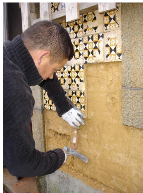
Fig. 11 – Reabilitação de fachada azulejar
