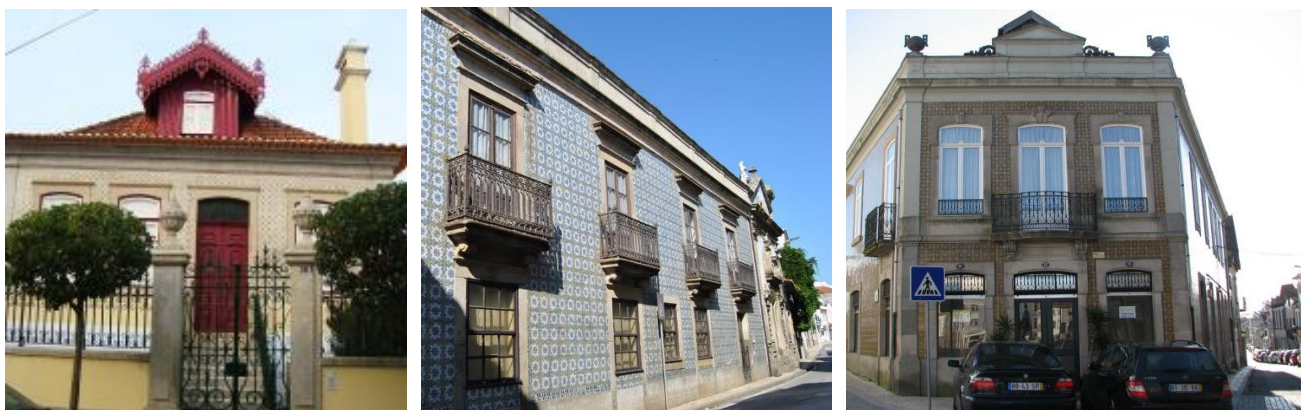
Fig. 2 - Edifícios com fachadas azulejadas e ornamentação.
