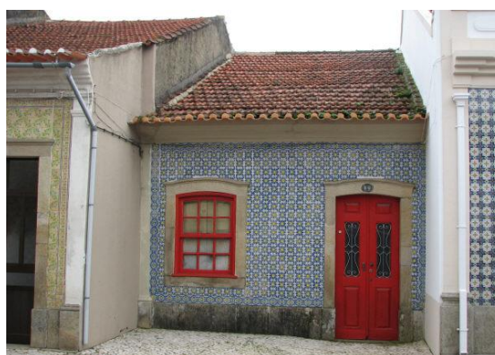
Fig. 19 – Rua Padre Ferrer (janela/porta)
