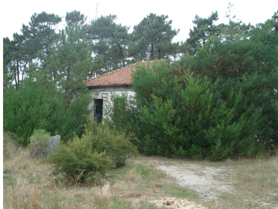
Casa da Guarda Florestal do Furadouro - Ovar
