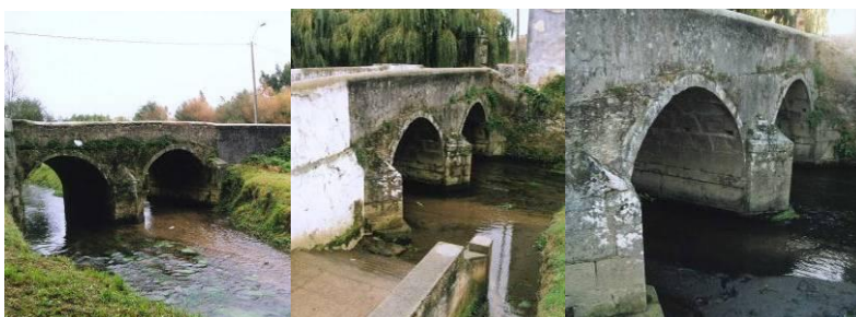
Figura 64. Ponte do Casal - Fonte: www.monumentos.pt
