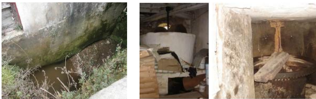
Figura 55. Sistema de Circulação de Água - Saída da Levada
