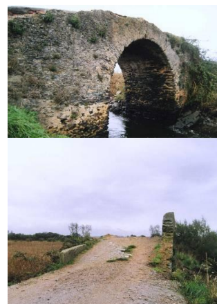
Figura 65. Ponte da Moita Fonte: www.monumentos.pt
