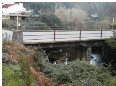
Figura 66. Ponte da Moita Fonte: www.monumentos.pt
