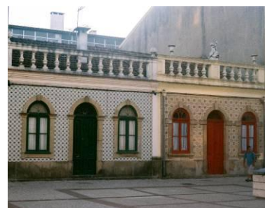
Figura 74. Edificado do Conjunto da Praia do Furadouro
